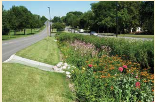
Exemple d'une écobaissière pour augmenter l'absorption d'eau dans le terre-plein d'une route.
